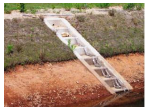
斜樋と取水栓（コンクリート製品）
