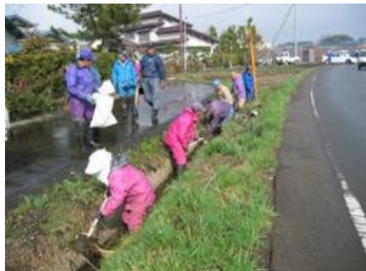
側溝の泥上げ
