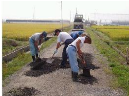
共同作業による砂利の敷き均し
