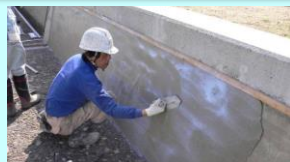
老朽化した水路壁のコーティング
