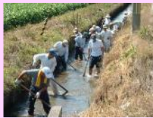
水路の泥上げ
