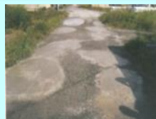
農道の窪みの補修
