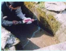
水路のひび割れ補修
