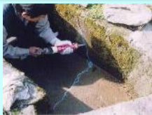
水路のひび割れ補修
