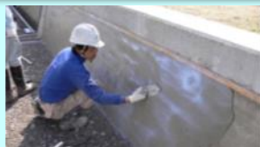
老朽化した水路壁のコーティング
