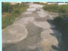
農道の窪みの補修
