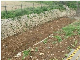
除去後の沈舎地
