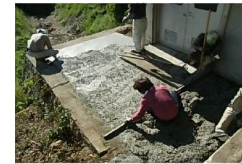
簡易的なコンクリート打設
