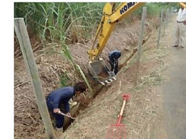
側溝の泥上げ
