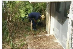
付帯施設周辺の草刈り
