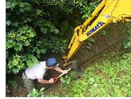
側溝の清掃作業
