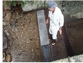
取水口の清掃作業
