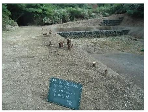
伐採撤去後の沈砂地
