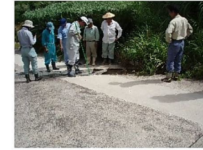
農道等の点検作業
