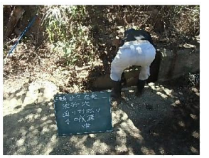
側溝の泥上げ
