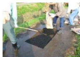
農道の補修 (対象組織が実施)
