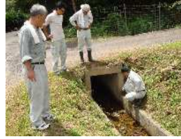
排水路の清掃作業
