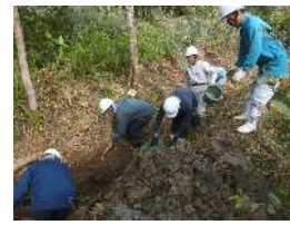
側溝の清掃作業
