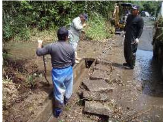
側溝の清掃作業
