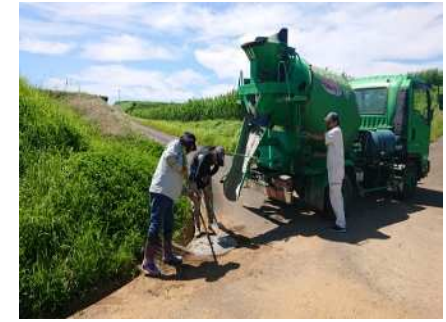
農道陥没箇所の補修作業
