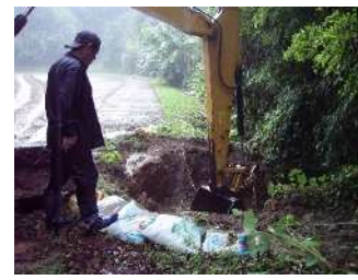
大雨で崩れた農地の復旧作業
