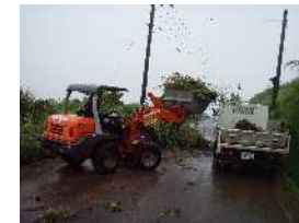
大雨後の現場確認及び泥上げ
