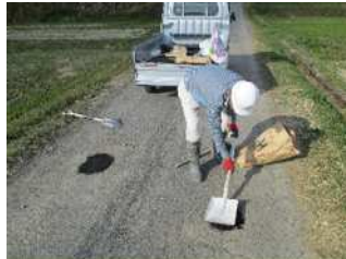
【農道の補修作業】
