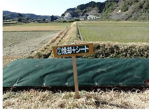
施工看板設置(パターン2)
