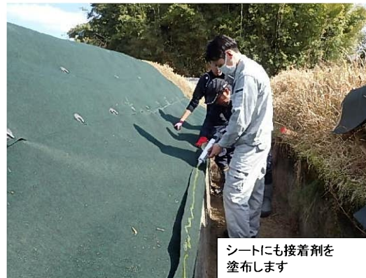
接着剤塗布状況
