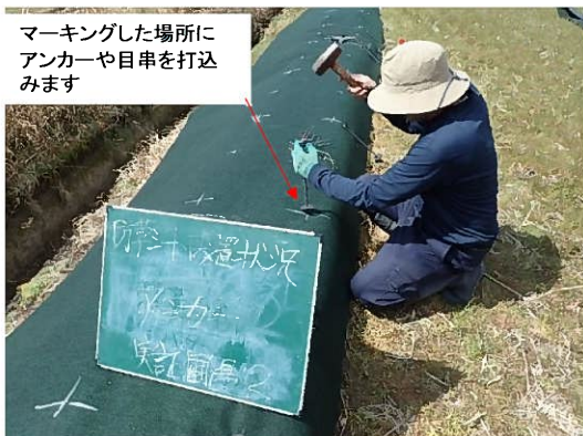
アンカー打ち込み状況
