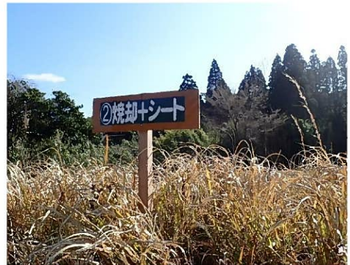
施工看板設置②
