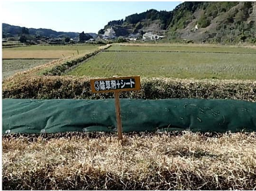
施工看板設置(パターン3)
