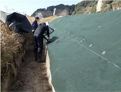
継ぎ目処理状況（接着剤使用）
