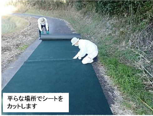
防草シートカット作業
