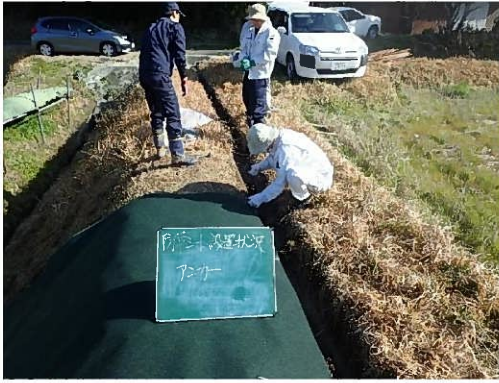
目串施工状況
