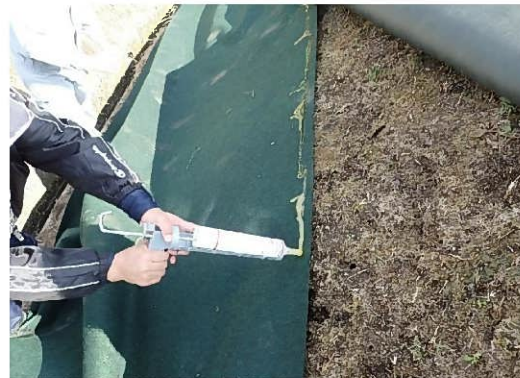
継ぎ目処理状況
