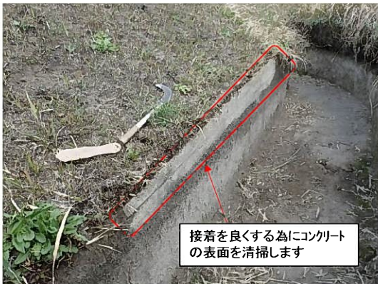
水路部施工状況（清掃）
