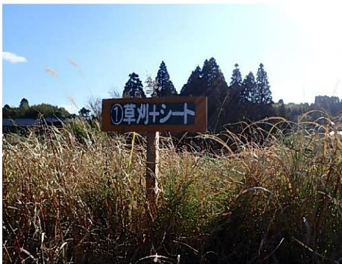
施工看板設置①
