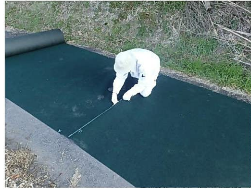
防草シートカット作業
