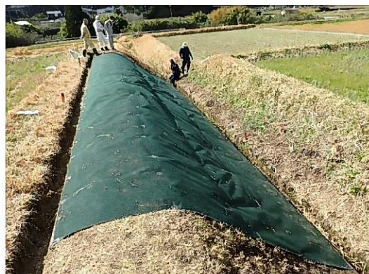
完成(用水路側)
