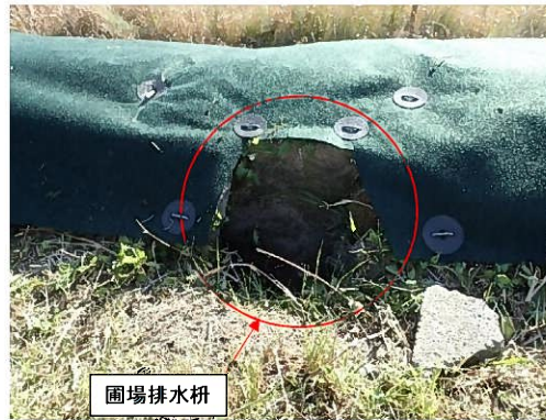
完成(圃場排水柵付近)
