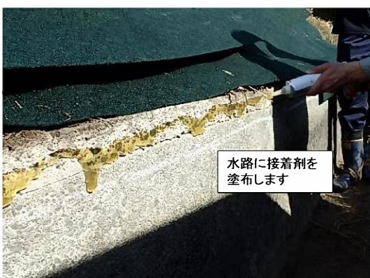
接着剤塗布状況
