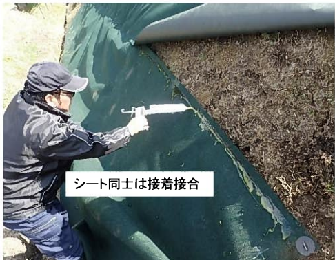
継ぎ目処理状況
