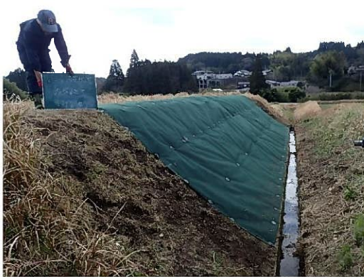
完成(排水路側)
