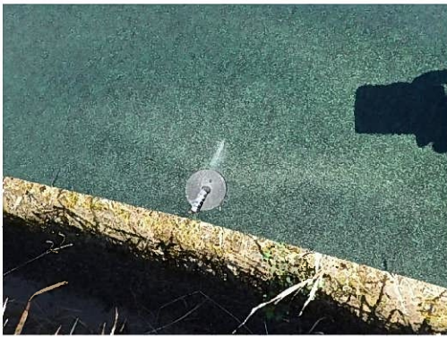
アンカー打ち込み完了
