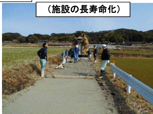
農道の舗装(自主施工)
