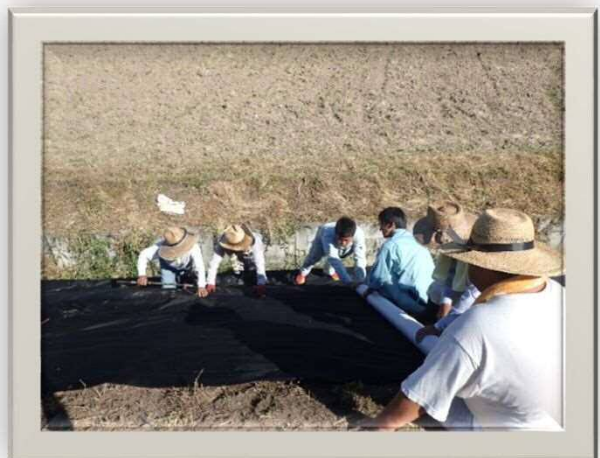
防草シートによるきめ細やかな雑草対策
