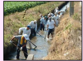
水路の泥上げ
