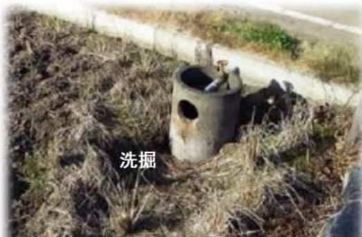
□給水栓ボックス基礎部の補強（洗掘）
