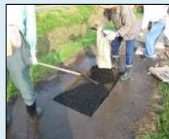
農道の部分補修
