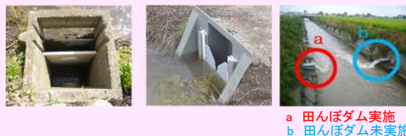
流出を抑制する落水量調整装置の例
