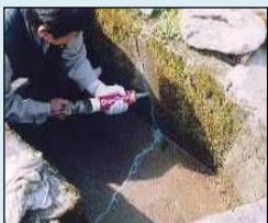
ひび割れの補修
