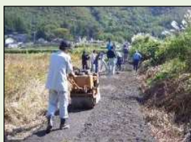
末舗装農道の舗装
