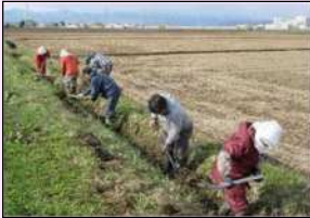
水路の泥上げ
