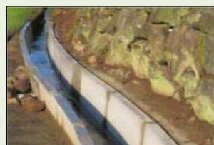
素堀り水路からの更新
