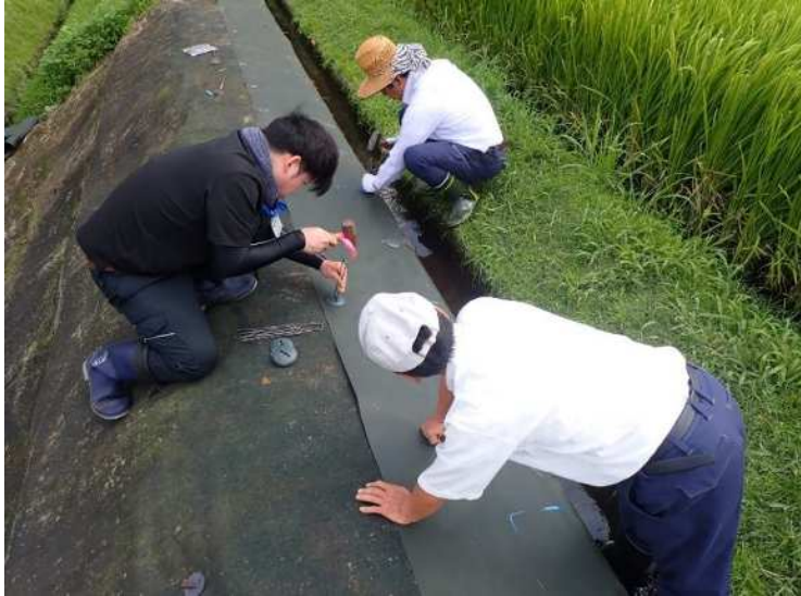
①用水路接続部破損箇所の補修状況 (R7年8月)
