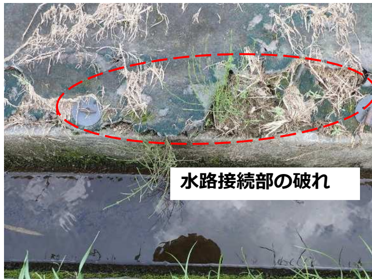
③排水路接続部破損状況 (R7年7月)
