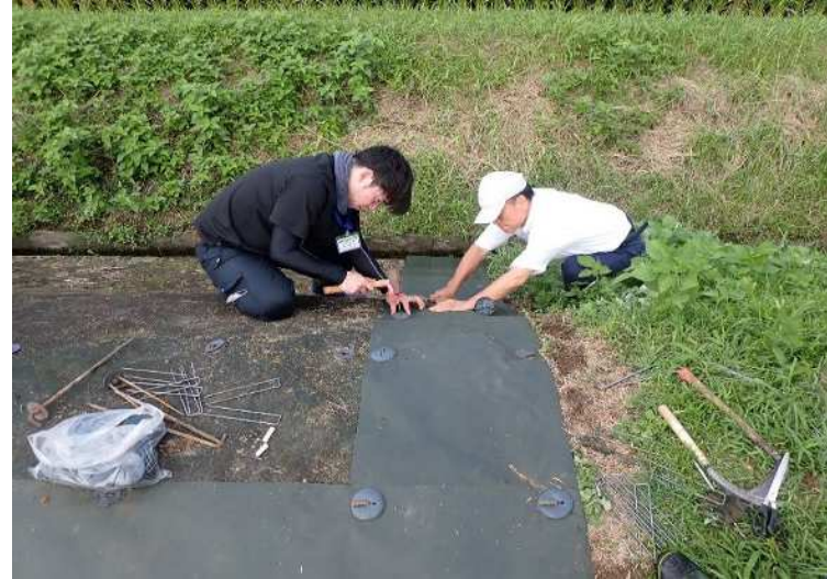
②シート端部補修状況 (R7年8月)
