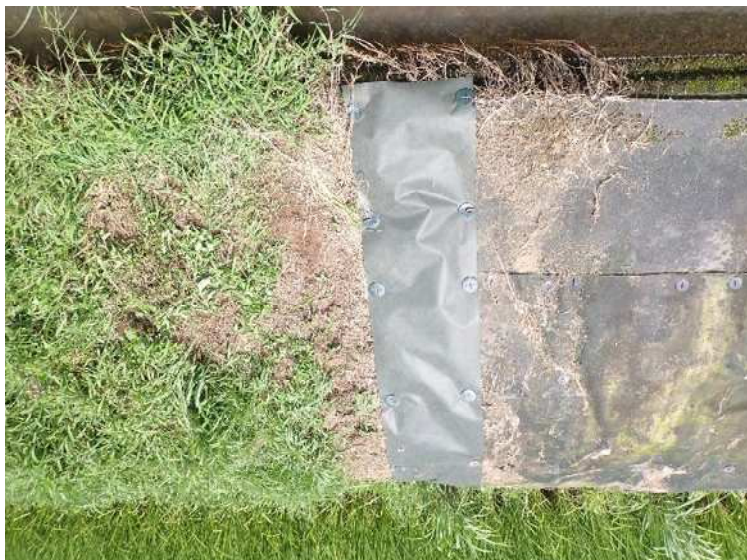
③シート端部補修完了 左側（R7年8月）
