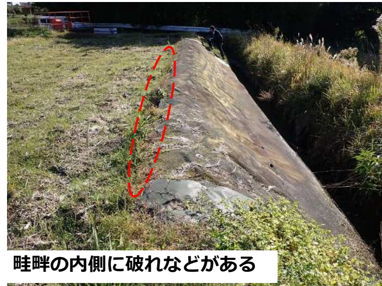
②畦畔の内側は耕作機械等の接触による破損がある。（R2年2月）
