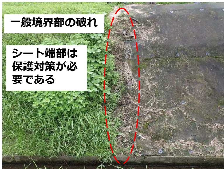
③シート端部破損状況（R7年7月）
