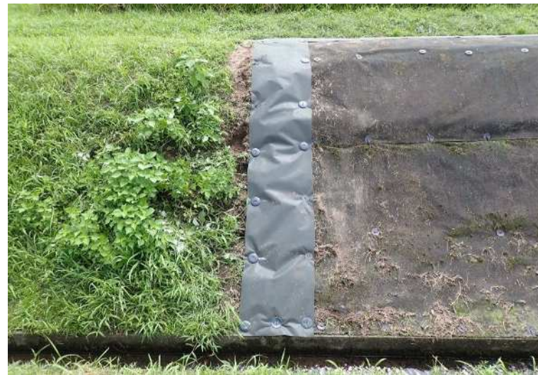
④シート端部補修完了 (R7年8月)
