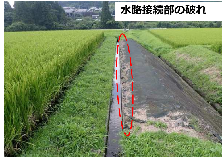
②用水路接続部破損状況（R7年7月）
