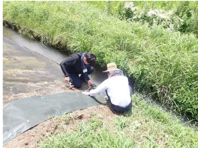
②シート端部補修状況（R7年8月）
