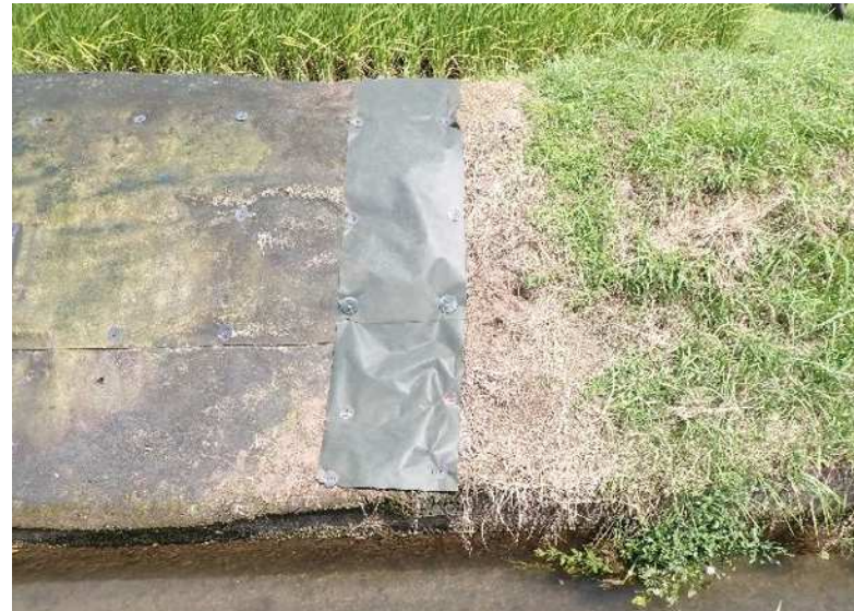
④シート端部補修完了 右側（R7年8月）
