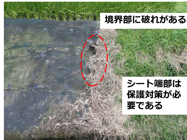
④シート端部破損状況（R7年7月）
