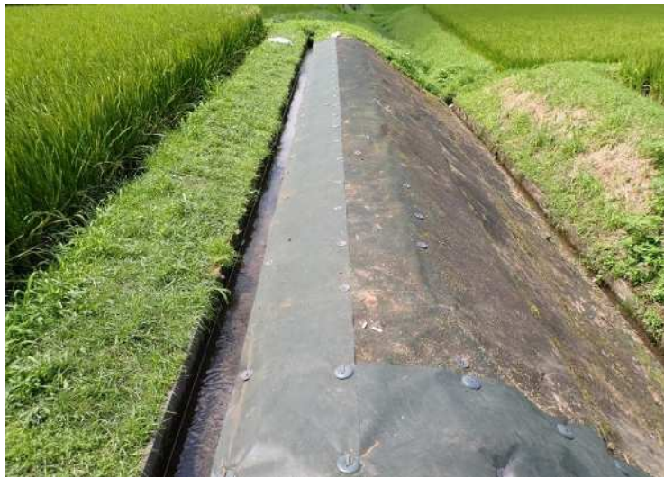
③用水路接続部補修完了 (R7年8月)
